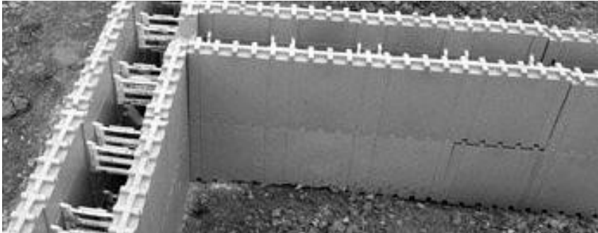
Rys. 2. System Isoteq stosowany do produkcji ścian w budownictwie energooszczędnym i pasywnym
